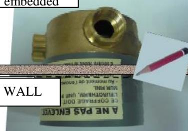
Tracer le coffrage plastique au ras du mur fini et le couper. Le remettre en place après découpe.
