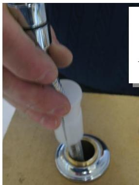
10) Descendre la pièce plastique dans le coulant sans engager l'écrou conique du flexible.
