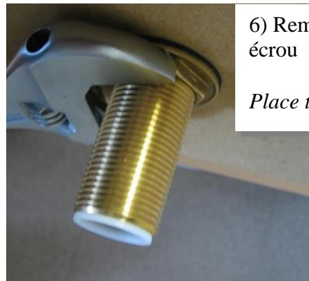
6) Remettre le caoutchouc noir et serrer le contre écrou
