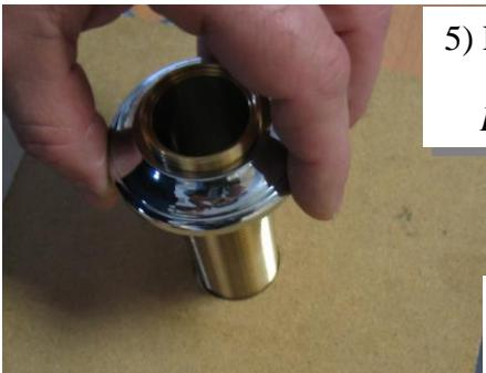
5) Positionner le coulant dans le trou diam 35 prévu sur la plage de baignoire.
